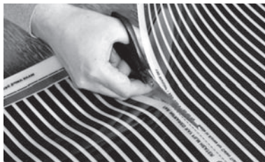
Рис. 4. Разрезание термопленки CALEO по линиям отреза
