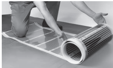
Рис. 3. Раскатывание рулона теплового пола на теплоотражающем материале
