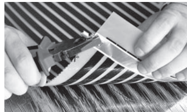
Рис. 6. Крепление контактного зажима к термопленке
