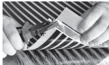
Рис. 6. Крепление контактного зажима к термопленке
